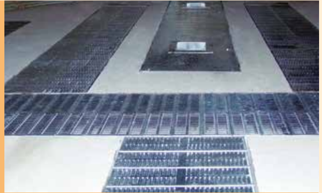
■ Vorfabrizierter Belüftungskanal – perforiertes Schlauchblech.
