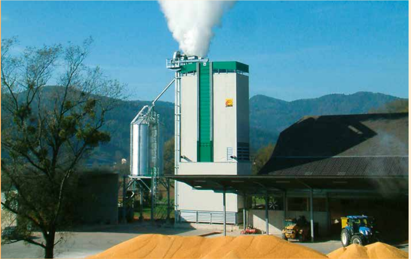
■ Industrielle Trocknungsanlage ERCL mit inkorporierter langsamer Kühlung.
