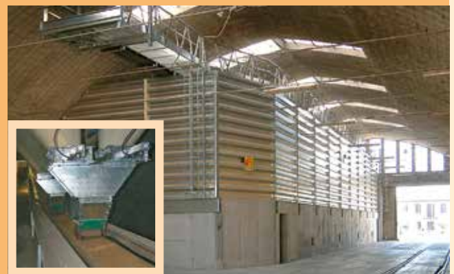
■ Quadratzellensilos mit Entlaclungsanlage.
