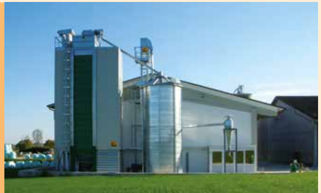
■ Anlage FIX-DRY mit separater Langsamkühlung und Beladung in horizontales Magazin.
