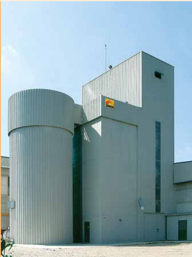
■ Trocknungsanlage zur Erreichung hoher Qualität und Leistungsgrad mit isolierter Langsamkühlung.
