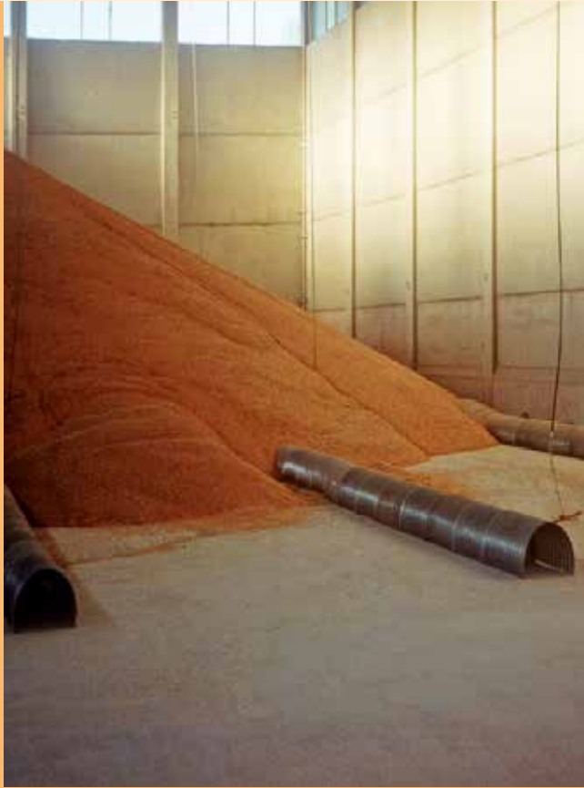
■ Belüftungssystem mit Halbrundkanälen.
